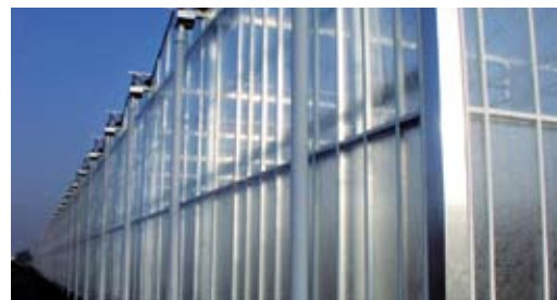
когенерация для тепличных комплексов на основе газовых двигателей GE Jenbacher
