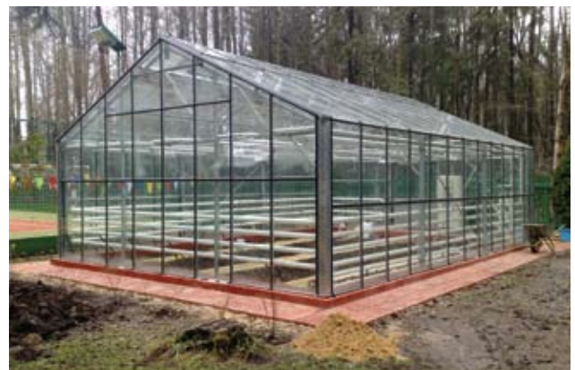
Обеспечение микроклимата в блочной теплице
