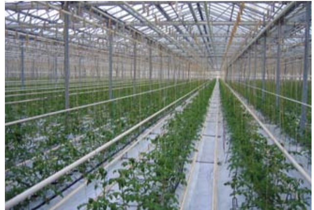
Обеспечение микроклимата в блочной теплице
